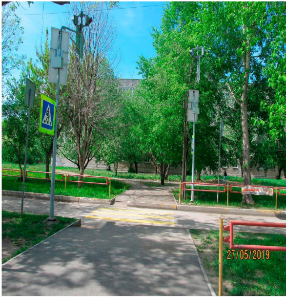
Пешеходный переход через ул. Тевосяна
